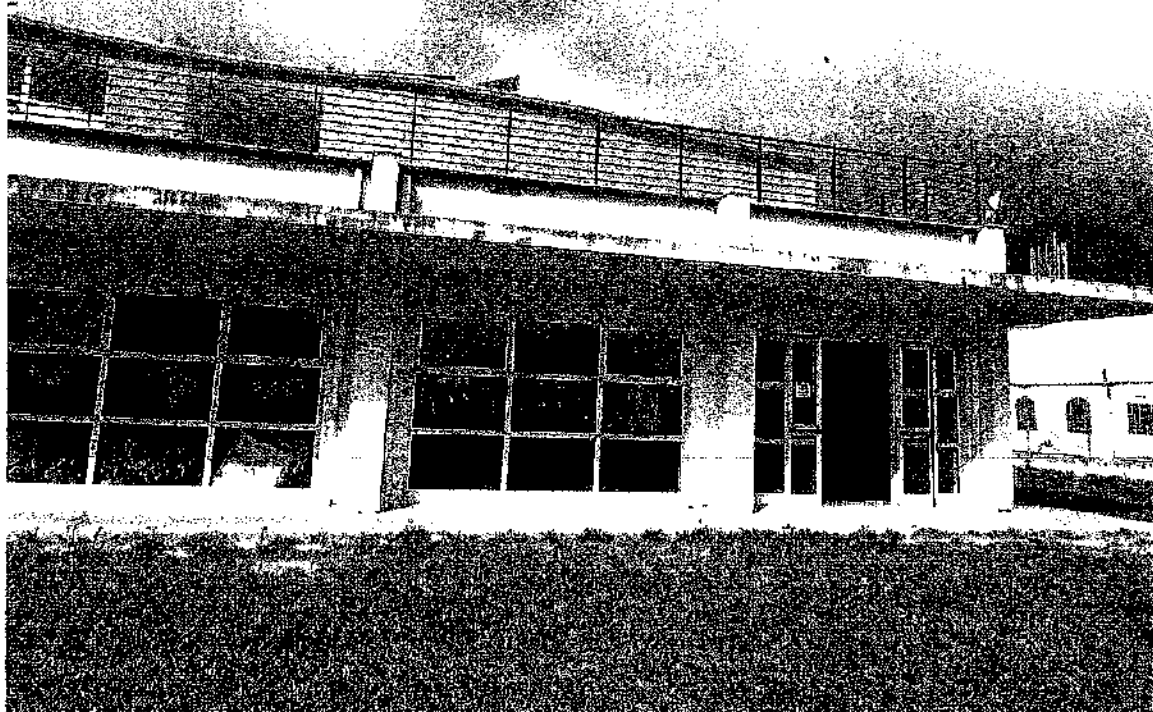
Foto 14. infissi, lato sud.
